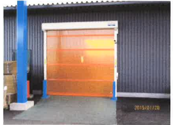
異物混入を防ぐため、営業からの要望で新たに設置されたシートシャッター
