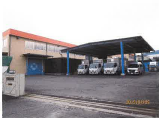
積荷時に雨風にさらされないよう 配送ドライバーの要望から設置された大屋根
